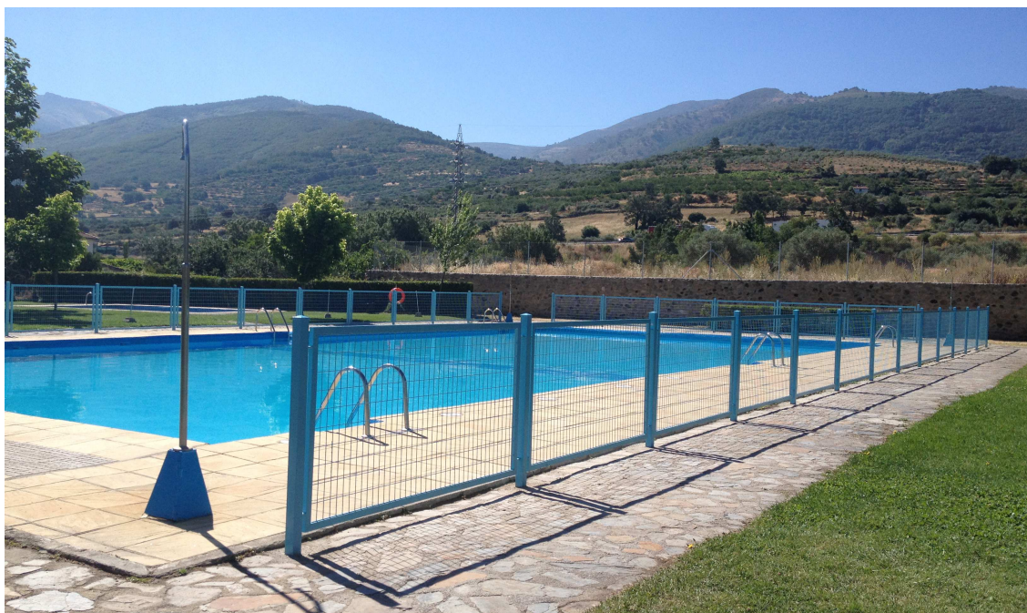
Vista de las instalaciones. Piscina polivalente de Adultos.
